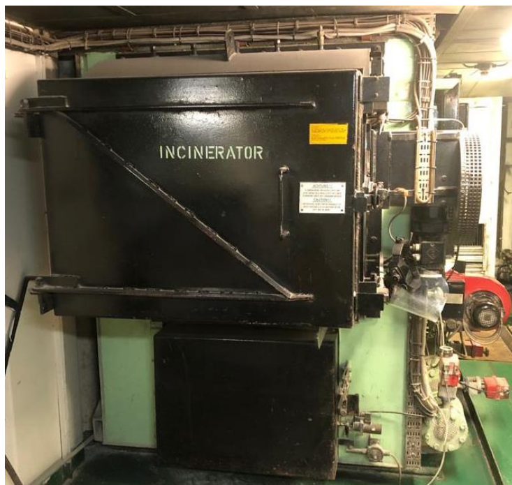
Slika 3. Uređaj za spaljivanje na brodu Deutschland [1]
