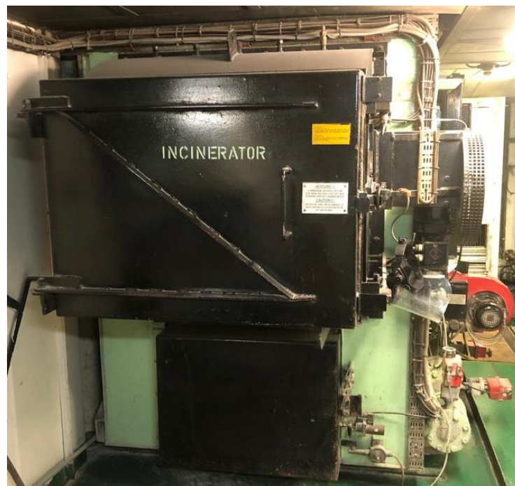
Slika 3. Uređaj za spaljivanje na brodu Deutschland [1]
