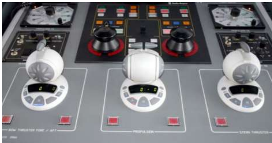
Slika 46. Komande na mostu [26]
