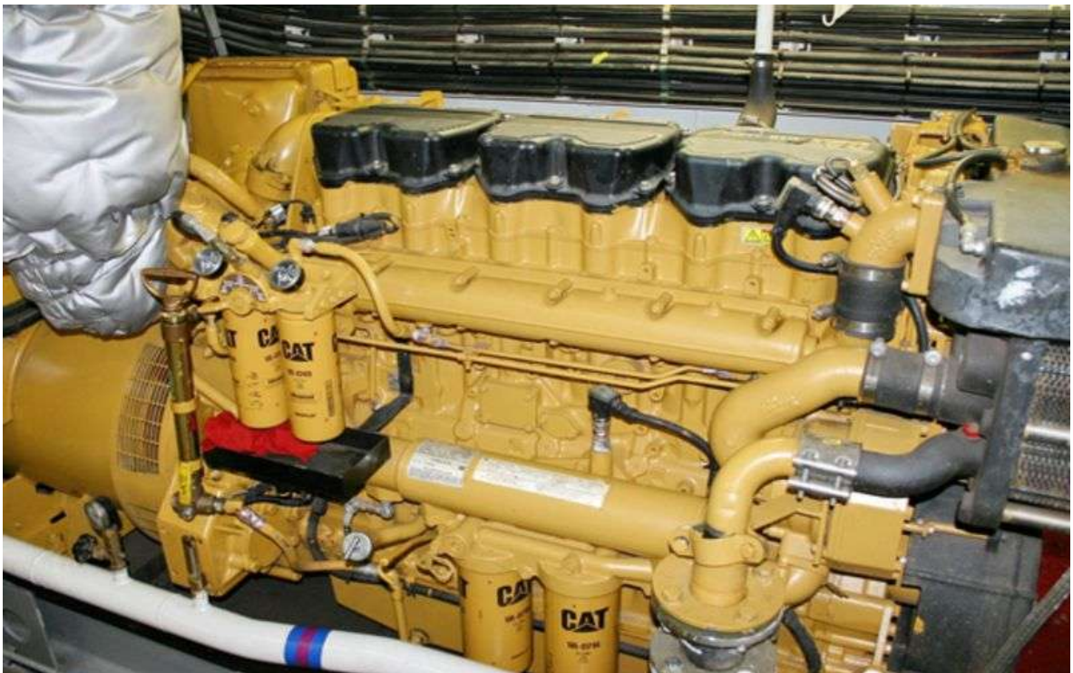
Slika 43. Brodski motor CAT C280-12 4060 kW [27]
