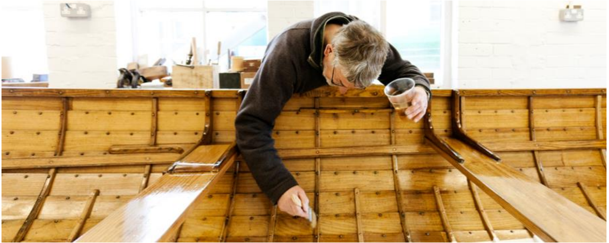
Slika 47. Jedna od faza brtvljena drvene konstrukcije po West sistemu (zaštita epoksidnom smolom) drvene gradnje
