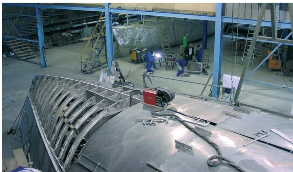
Slika 25. Proces zavarivanja aluminija u zatvorenom prostoru [39]
