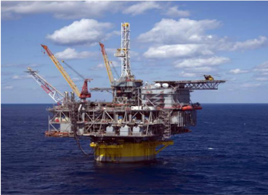
Slika 21. Perdido spar platforma [3]
