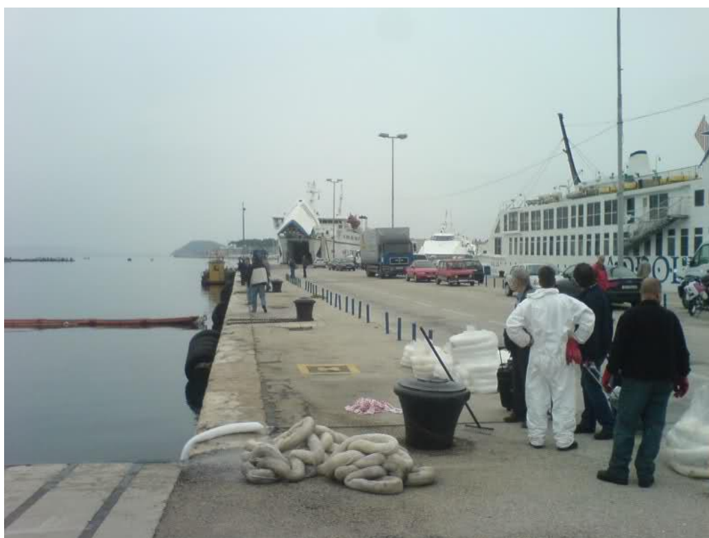
Slika 18. Sanacija izljeva i kobasice s upijačima [9]
