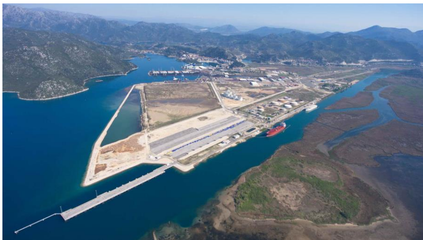
Slika 16. Opremanje terminala za rasute terete u luci Ploče [19]
