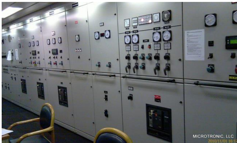
Slika 19. Prikaz glavne sklopne ploče [9]
