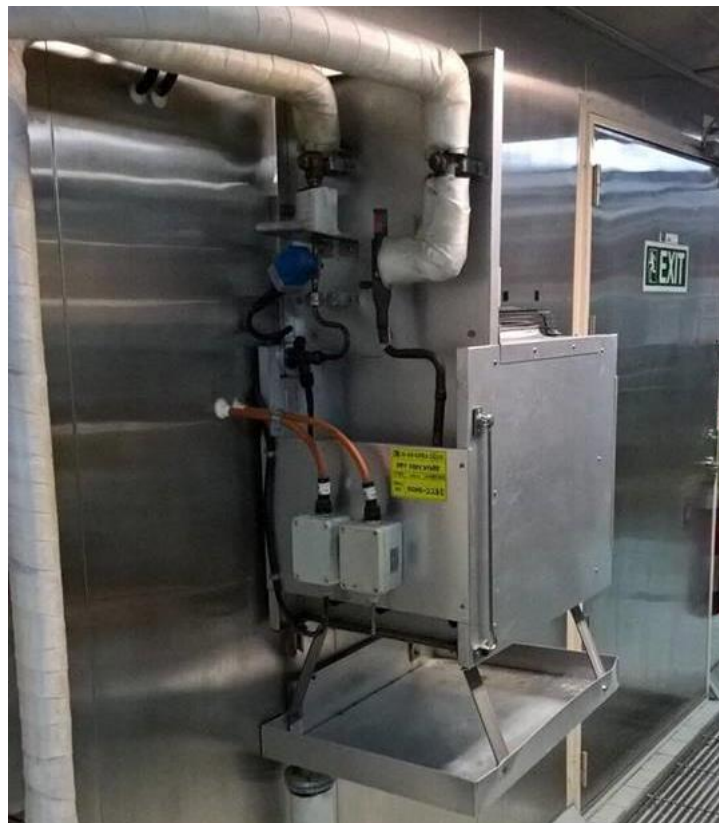
Slika 12. Primjer isparivača u komori [8]
