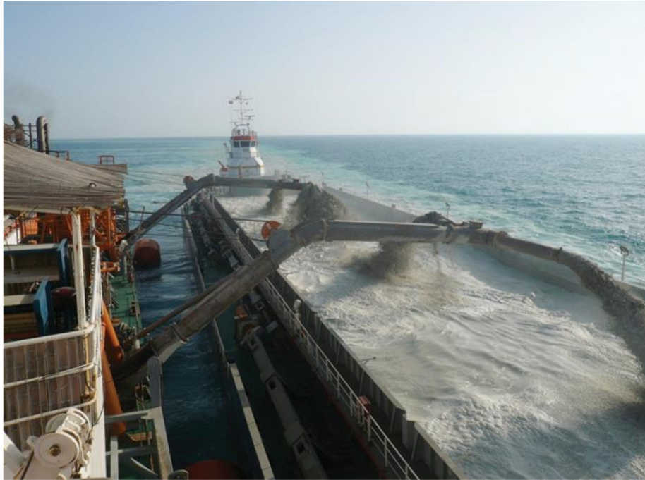
Slika 2. Iskrcaj iskapanog tereta na baržu [3]
