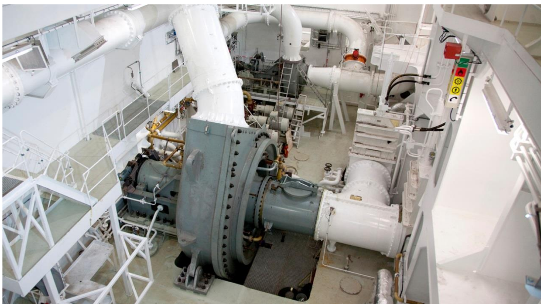
Slika 78. Pumpna stanica na TSHD jaružalu [38]
