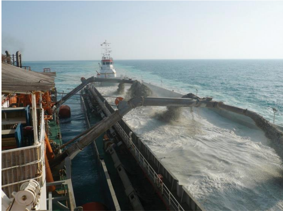
Slika 2. Iskrcaj iskapanog tereta na baržu [3]
