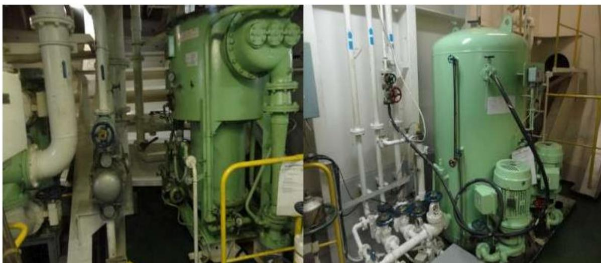
**Slika 5. Generator slatke vode na LNG brodu [11]**
