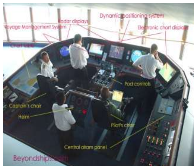
Slika 17. Raspored pozicija i glavnih sustava upravljanja na navigacijskom mostu [13]
