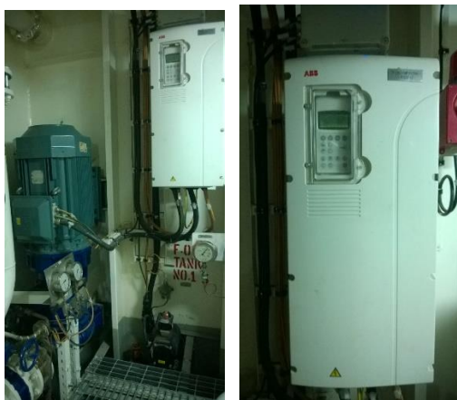
Slika 52. Pumpa-elektromotor upravljani frekvencijskim pretvaračem
