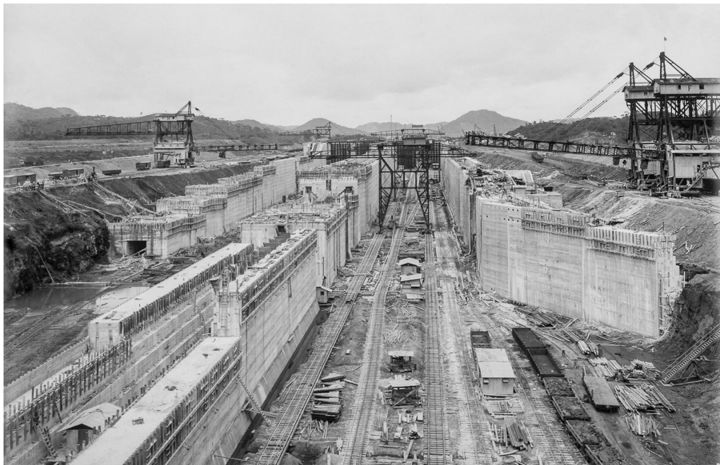
Slika 3. Izgradnja ustava [6]
