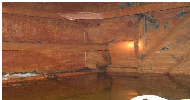
Slika 25. Učinci korozije na tankovima za teret[6]
