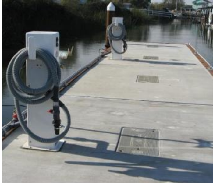
Slika 4. Pumpa za prikupljanje otpadnih voda [39]
