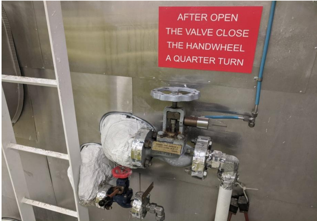
Slika 7. Brzozatvarajući ventil na liniji dovoda goriva u EDG daljinski zatvaran ručicom hidrauličkog cilindra
