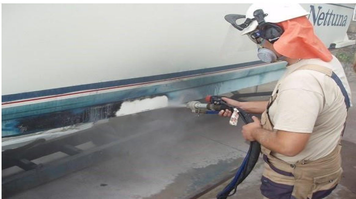
Slika 12. Pjeskarenje broskog trupa sodom [4]
