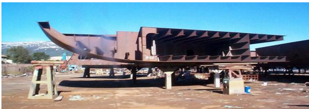
Slika 16. Sekcija dvodna [1]
