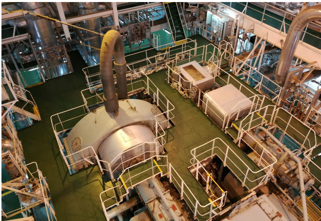
Slika 5. Brodska pogonska parna turbina
