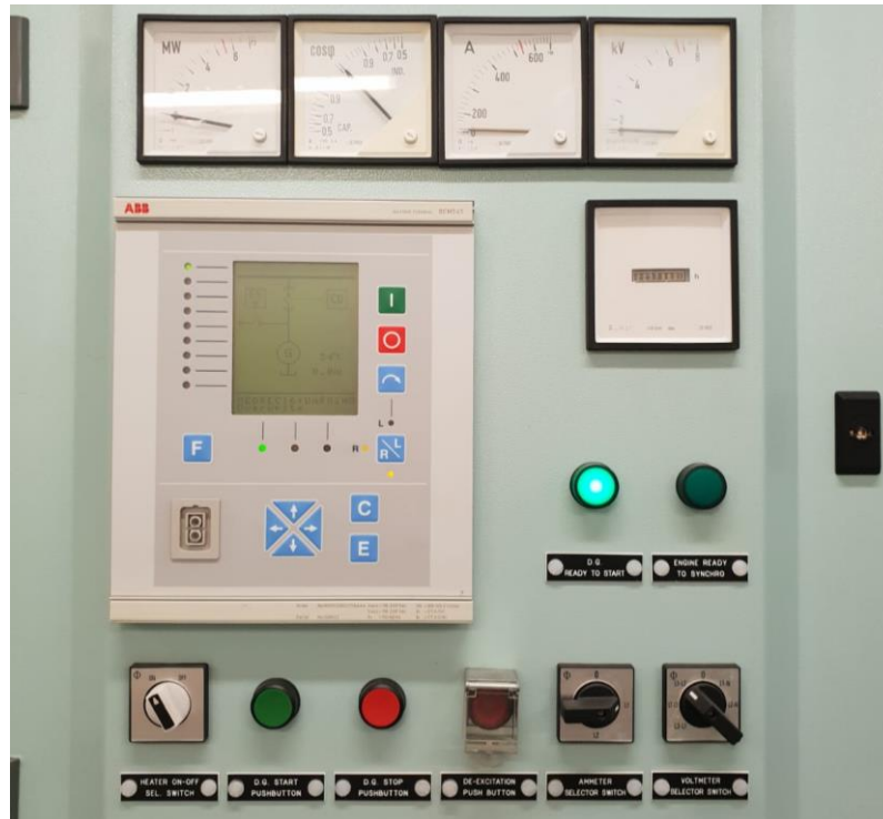
Slika 10. ABB REM615 u pogonu
