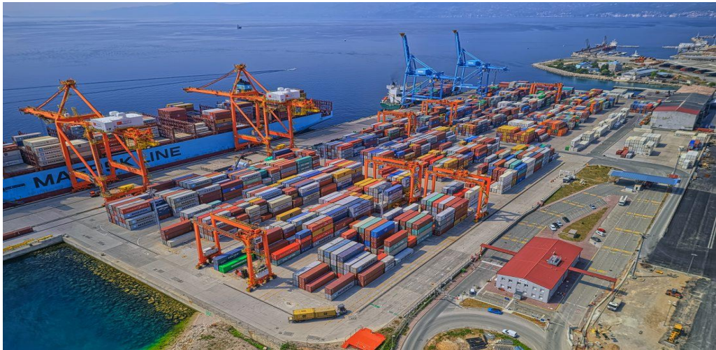
Slika 4. Kontejnerski terminal u Rijeci [24]
