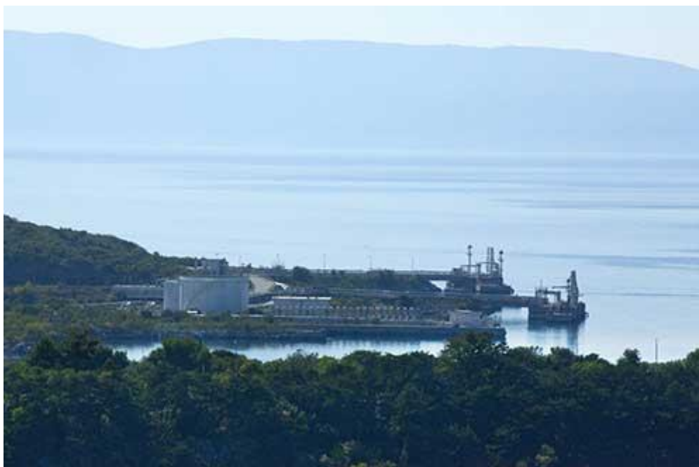
Slika 2. Primjer industrijske luke - LNG terminal na Krku [38]
