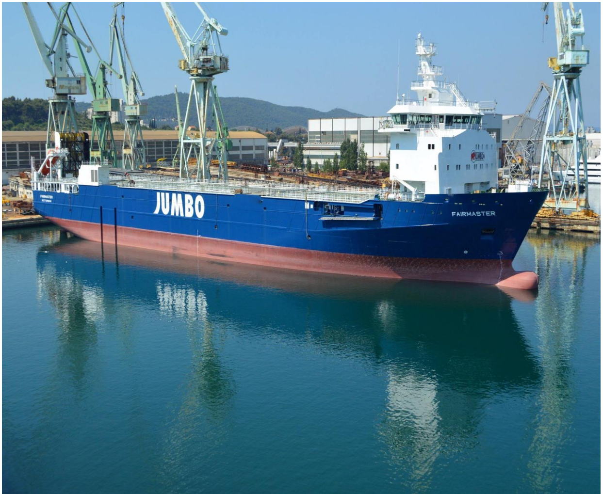
Slika 69. Fairmaster u splitskom brodogradilištu – završni radovi [2]
