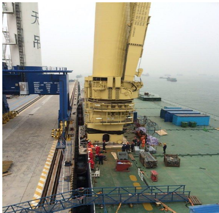
Slika 71. Ugradnja palubne dizalice – Fairmaster [2]
