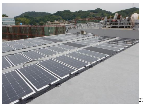
Slika 7 Solarne čelije na brodu MS Paolo Topic [27]
