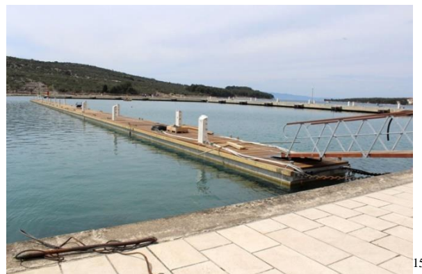
slika 5 ACI marina Cres, montiranje pontona [15]
