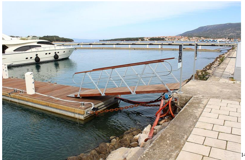
Slika 4 ACI marina cres - novoizgrađeni ponton [14]
