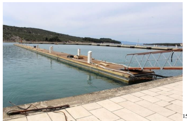
slika 5 ACI marina Cres, montiranje pontona [15]
