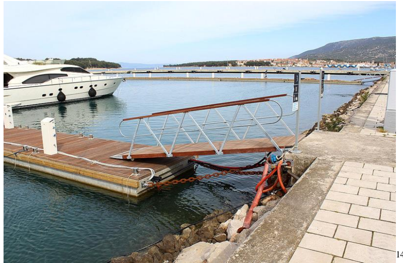
Slika 4 ACI marina cres - novoizgrađeni ponton [14]
