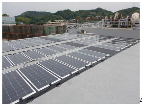
Slika 7 Solarne čelije na brodu MS Paolo Topic [27]
