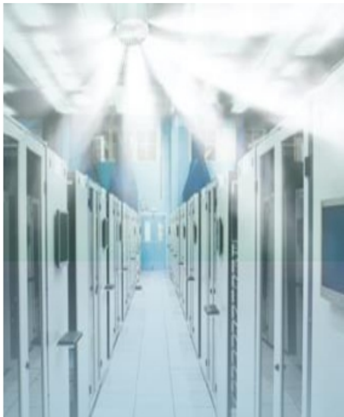
Slika 20. Ispuštanje plina „NOVEC 1230“ u računalnoj prostoriji
