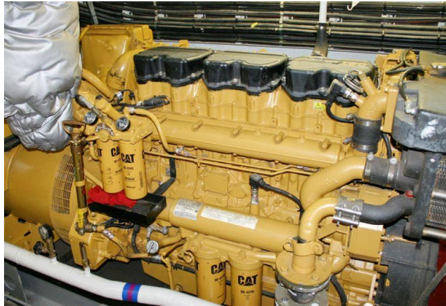
Slika 38. Dizel generatori na brodu Brodospas Beta [40]
