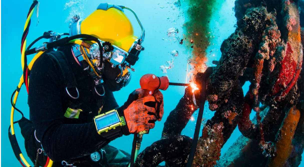
Slika 20. Podvodno rezanje [26]
