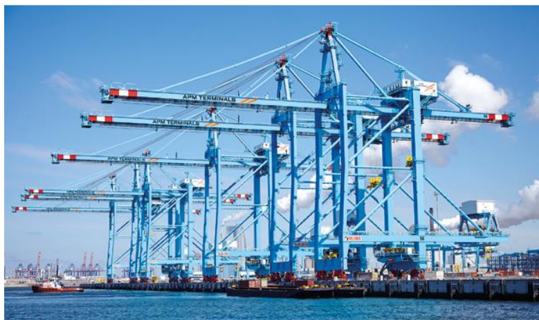
Slika 13. Automatizirane obalne dizalice (AQC) [14]
