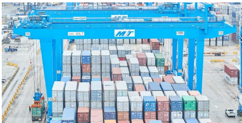
Slika 11. Bočno opsluživana automatizirana pokretna dizalica na kolosijeku sa bočnim nosačem (CARMG) [39]
