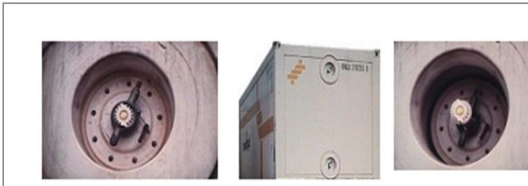
Slika 8. Otvori za isporuku i povratak zraka na vanjskoj jedinici [12]
