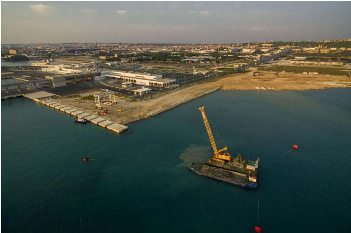
Slika 6. Obalni zidovi i zaštita nasipa Lot III C
