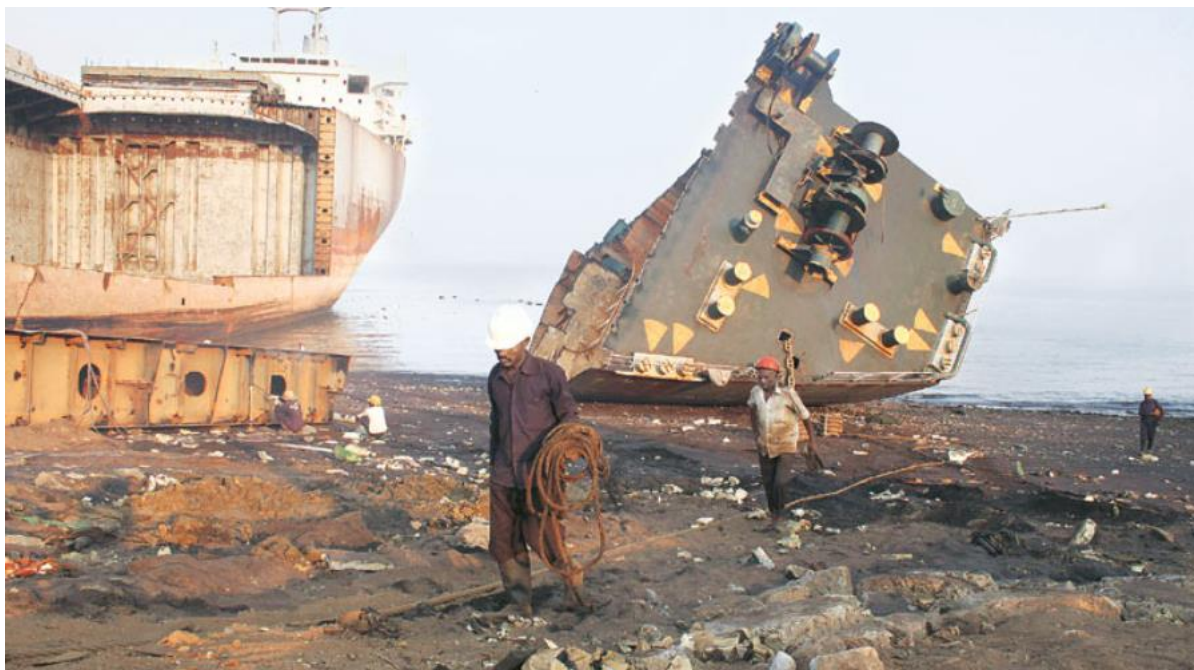
Slika 19. Rezanje sekcija na plaži u Bangladešu [18]
