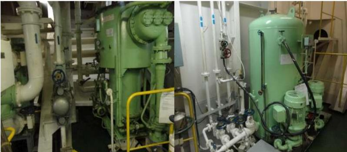
Slika 5. Generator slatke vode na LNG brodu [11]
