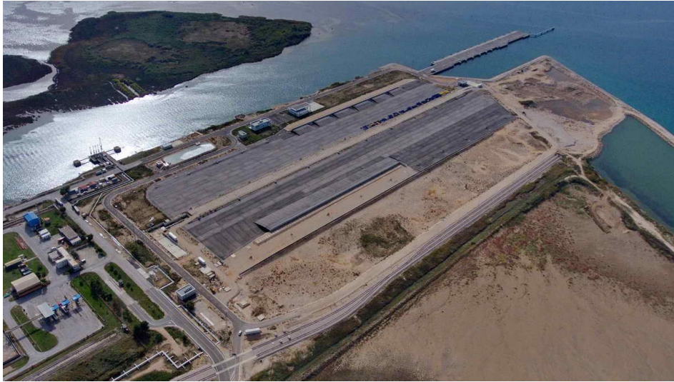
Slika 10. Područje Luke Ploče na kojem se gradi terminal za rasute terete[37]
