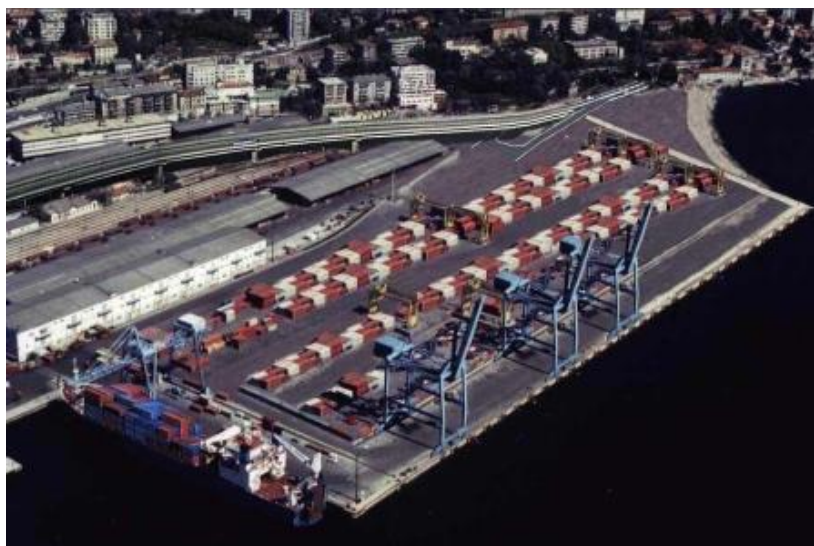
Slika 1. Kontejnerski terminal Brajdica[12]
