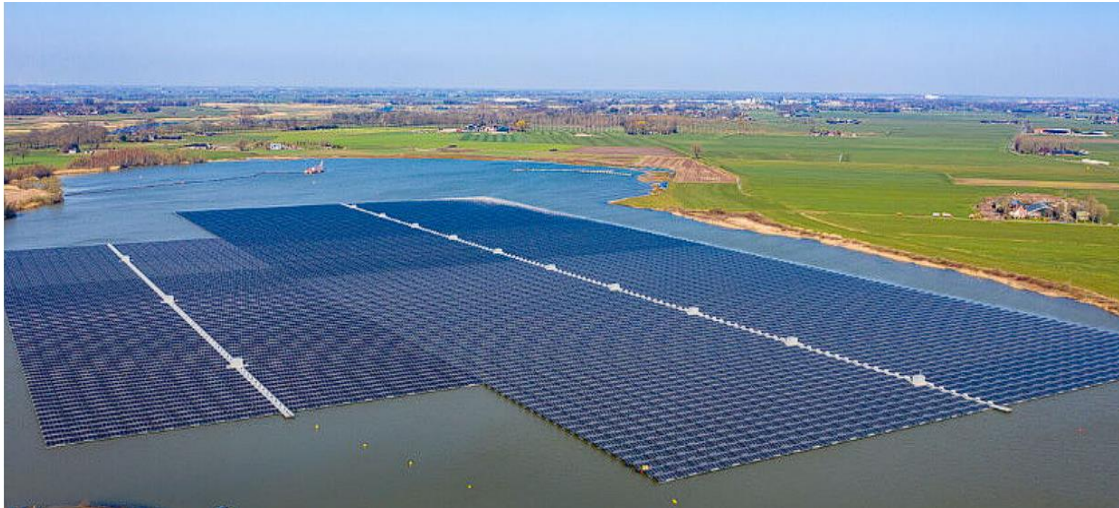
Slika 3. Plutajuće solarne ploče s 50 MW instalirane u Grčkoj [41]
