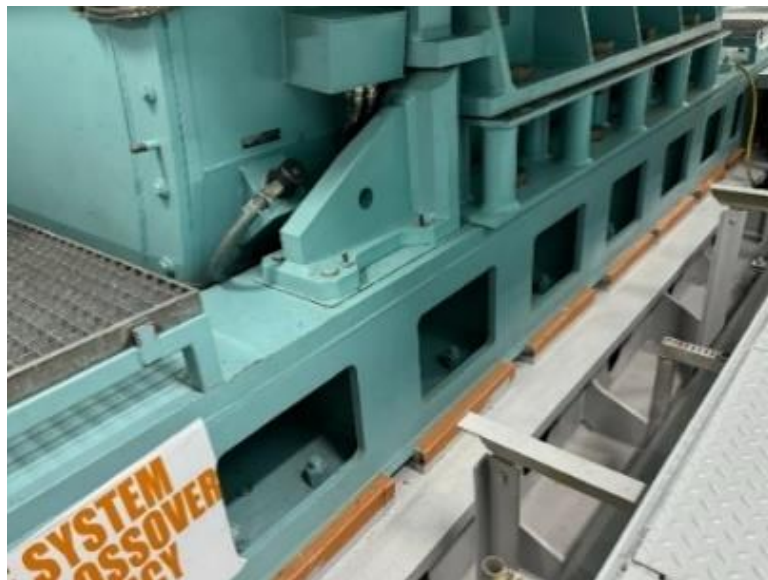
Slika 11. Temeljenje porivnog elektromotora na temeljima od epoksidne smole
