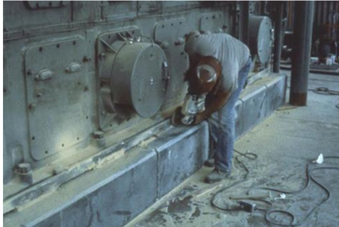
Slika 28. Naknadna obrada temelja od epoksidne smole [1]
