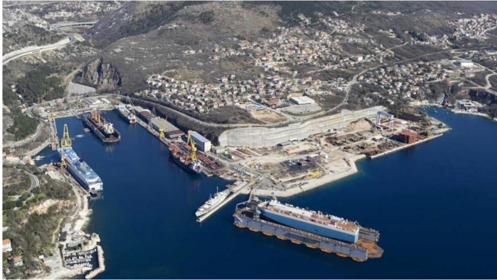
Slika 9. Remontno brodogradilište Viktor Lenac u Rijeci [18]
