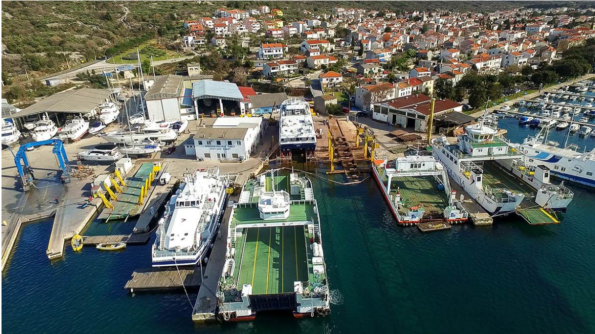
Slika 4. Remontno brodogradilište Punat na otoku Krku [13]
