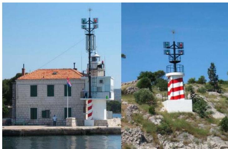
Slika 14. Semaforська svjetla na signalnim postajama Jadrija i Martinska [15]
