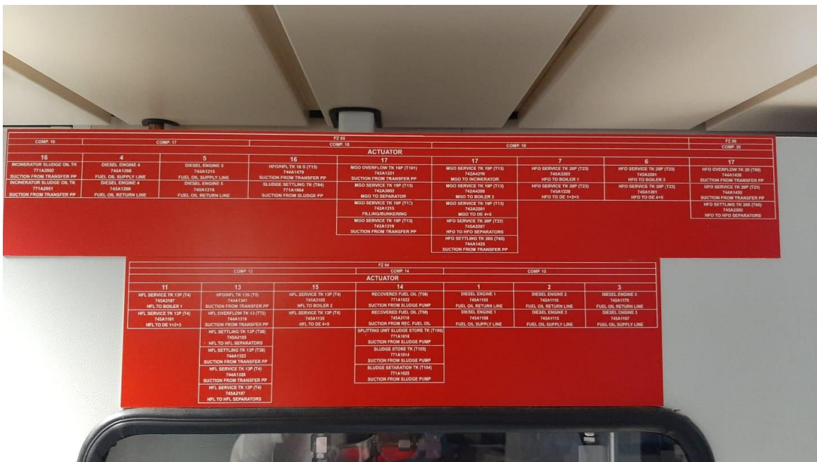
Slika 15. Primjer daljinski zatvaranih uređaja brzozatvarajućim ventilima.
