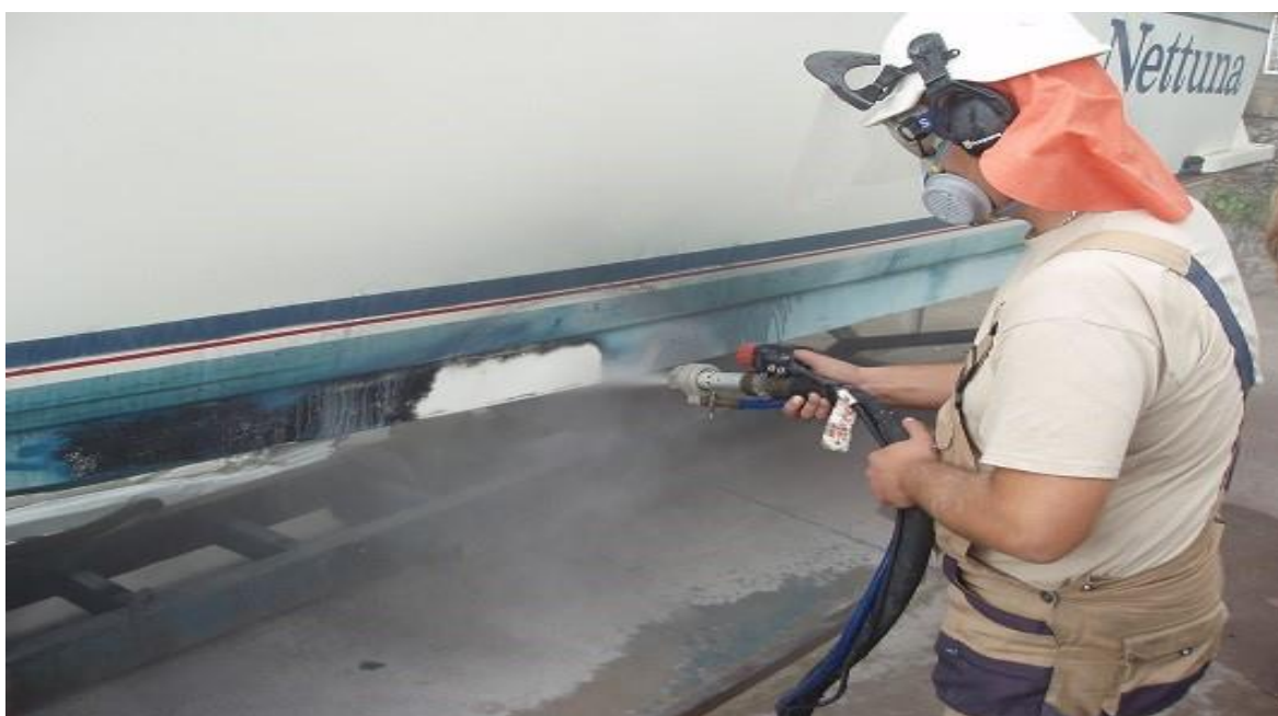
Slika 12. Pjeskarenje broskog trupa sodom [4]
