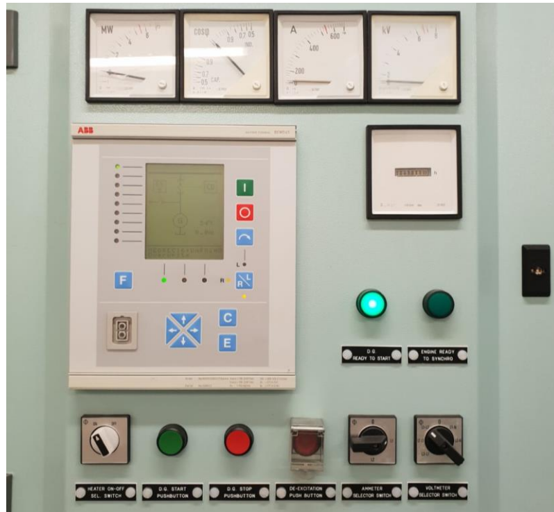
Slika 10. ABB REM615 u pogonu
