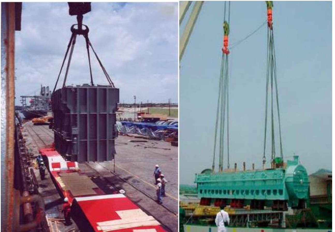
Slika 5. Kategorija tereta A - transformator pri podizanju na brod [28]
