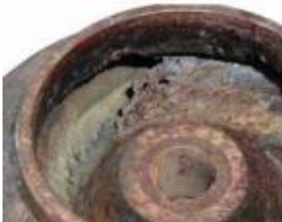
Slika 9. Kavitacijska oštećenje rotora centrifugalnih pumpi [4]
