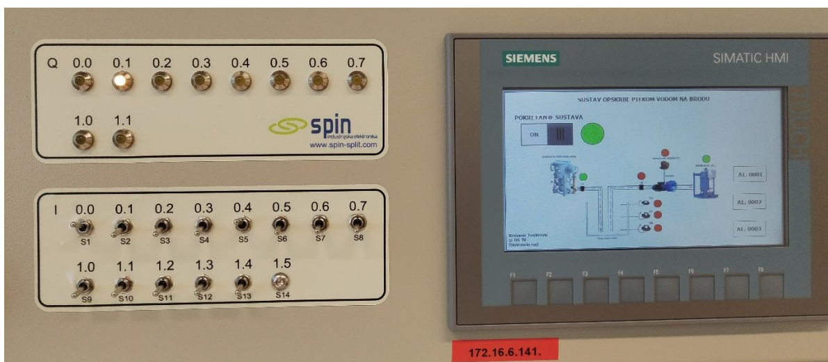
Slika 52. Paljenje generatora da ima protoka
