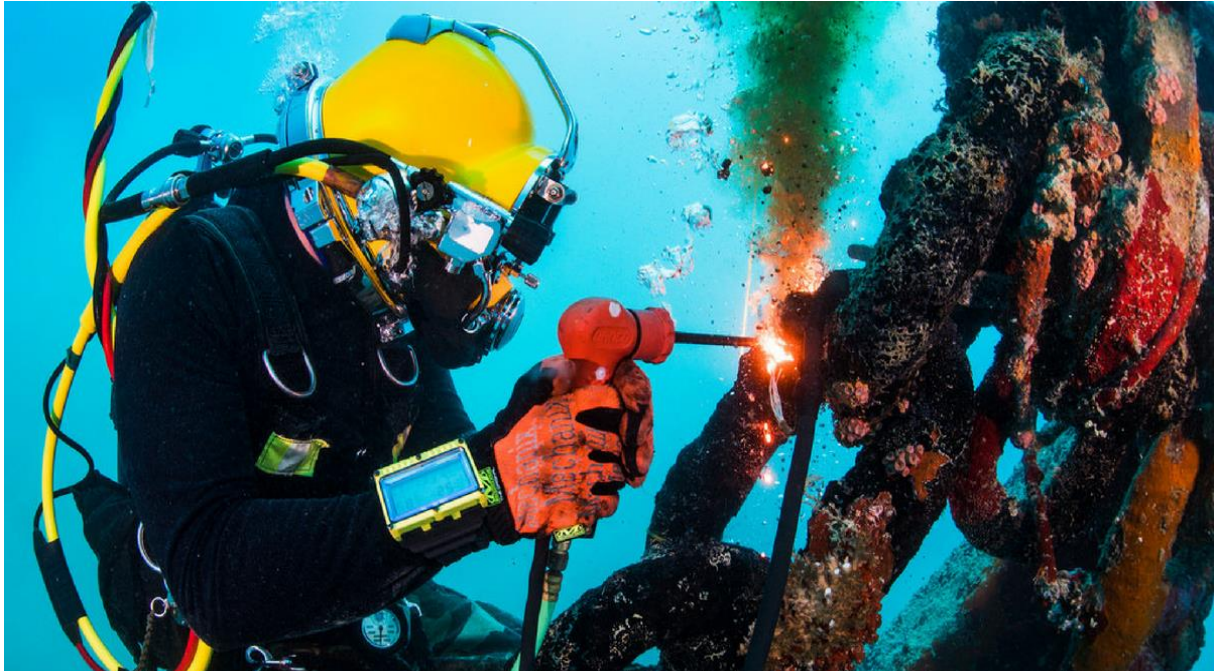
Slika 20. Podvodno rezanje [26]
