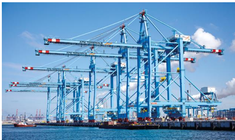
Slika 13. Automatizirane obalne dizalice (AQC) [14]
